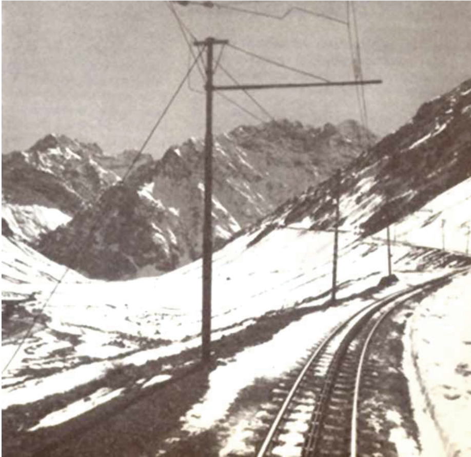
Electrificación ferroviaria como parte de los Planes Generales de la CORFO. Corporación de Fomento de la Producción, Veinte... , op. cit.
