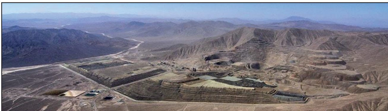
Imagen 37 - Faena Quebrada Blanca
