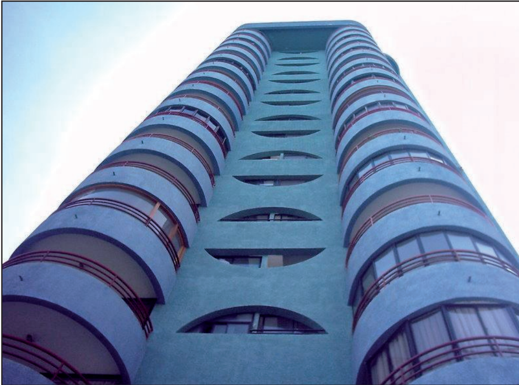
Imagen 16 - Edificio Crucero, Península de Cavanca Inmobiliaria Empresarial s.a. (1998)
