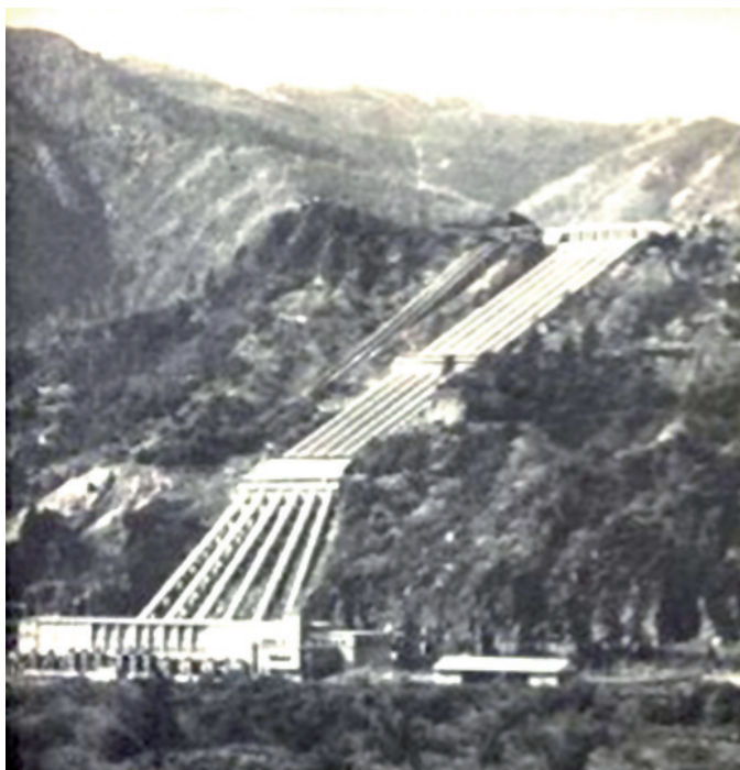
Central hidroeléctrica de Abanico (135.000 KW), ubicada en la actual VIII Región, “cuarta región geográfica” de acuerdo con el orden fijado por CORFO. Corporación de Fomento de la Producción, Veinte años de labor .
