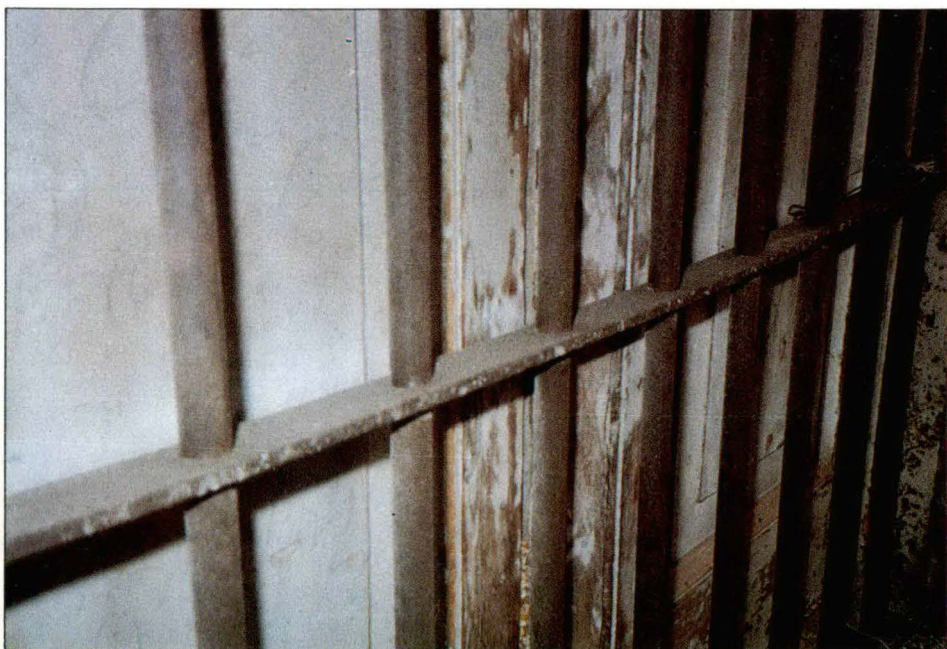
Foto 10 Detalle que muestra el paso del fierro
