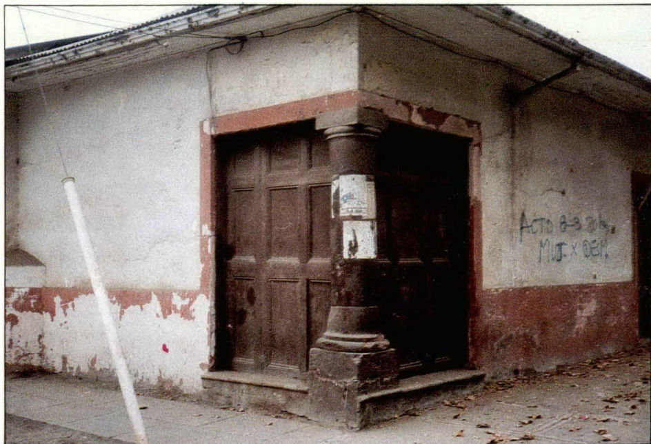
Foto 5 Casa con pilar en la esquina
