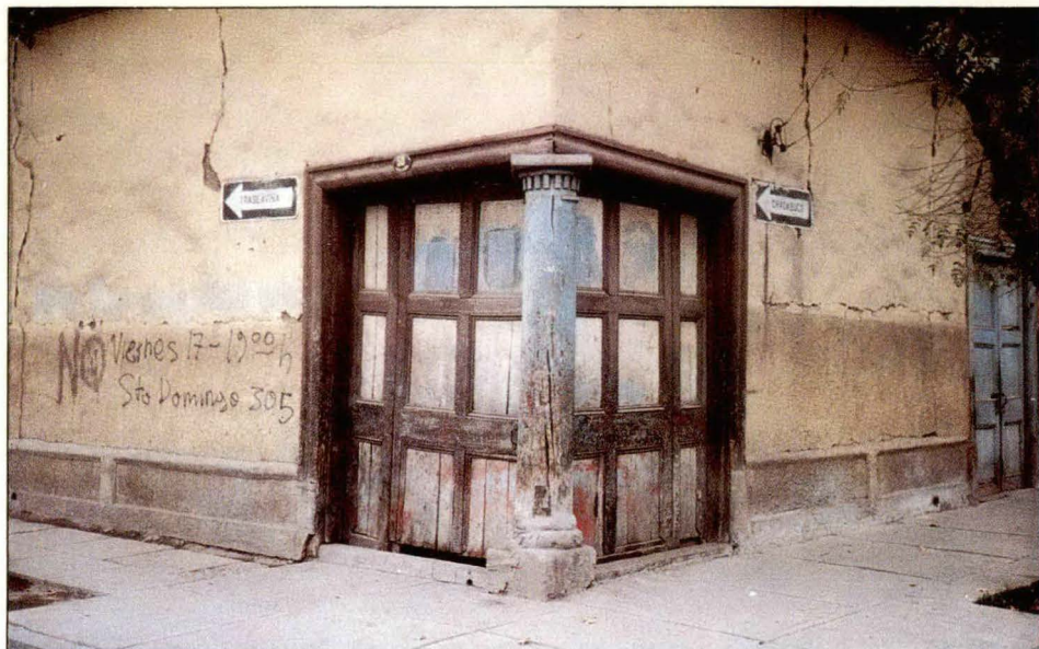
Foto 1 Casa con pilar en la esquina
