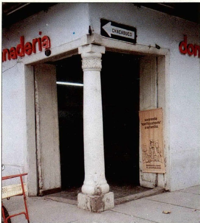
Foto 4 Casa con pilar en la esquina
