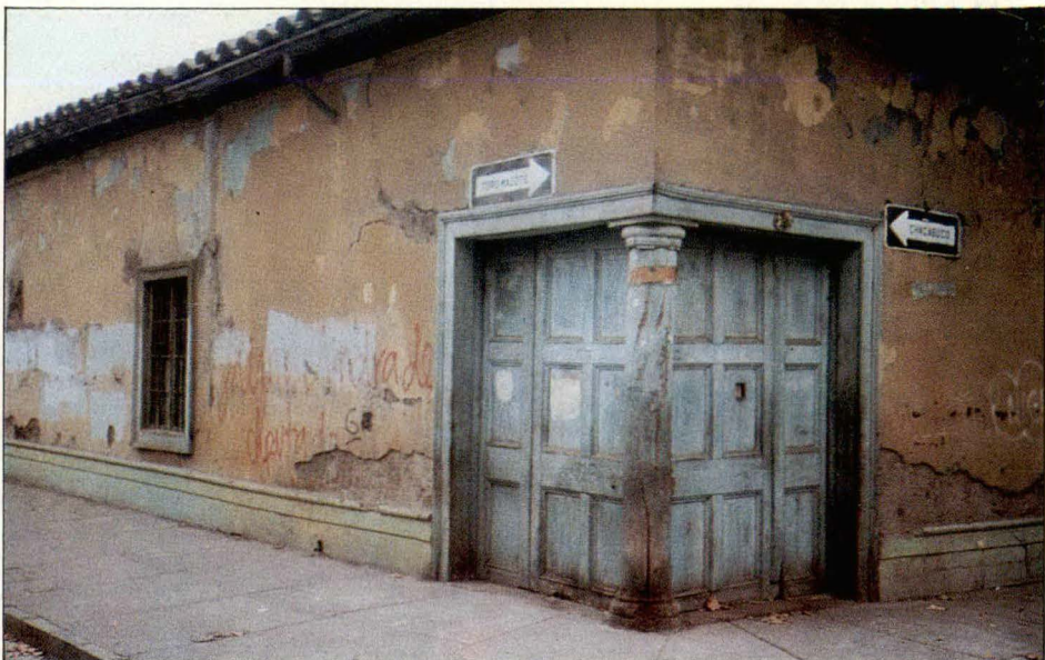
Foto 3 Casa con pilar en la esquina
