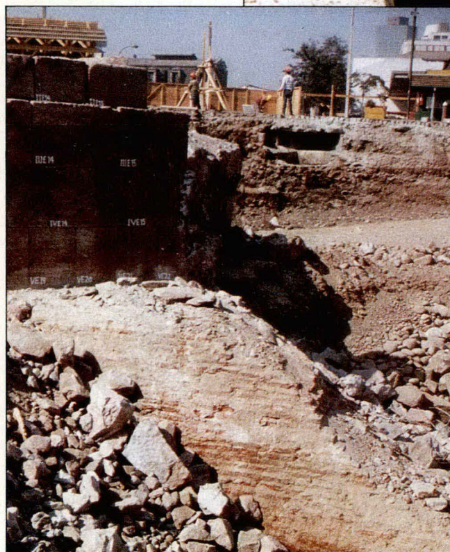
Foto 32 Tajamar junto al estribo sur.
