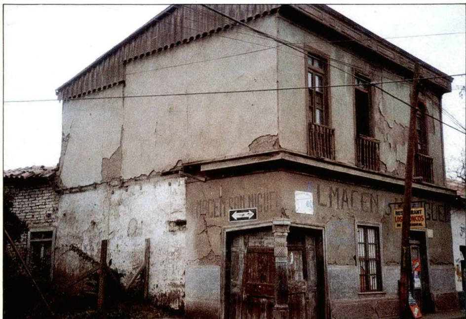
Foto 6 Casa con pilar en la esquina
