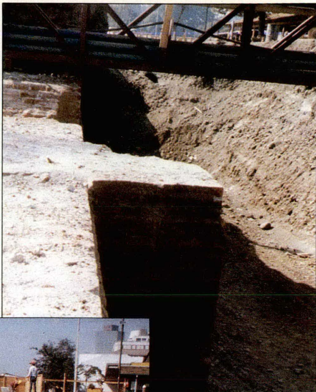
Foto 31 Contrafuertes traseros del tajamar.
