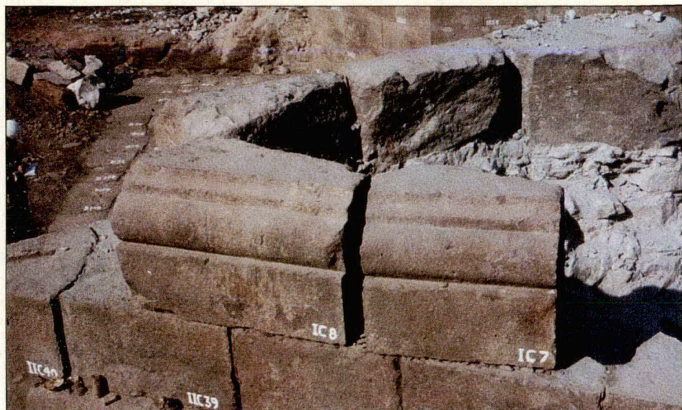
Foto 23 Cepa del Puente. Piedra exterior labrada.
