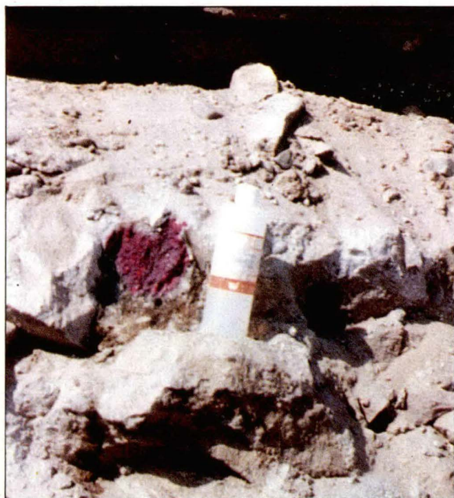
Foto 34 Cal no afectada por la humedad.
