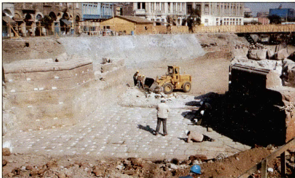
Foto 25 A la izquierda el estribo sur. A la derecha la primera cepa.
