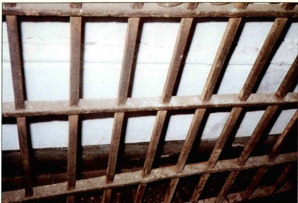
Foto 9 Detalle que muestra el paso del fierro
