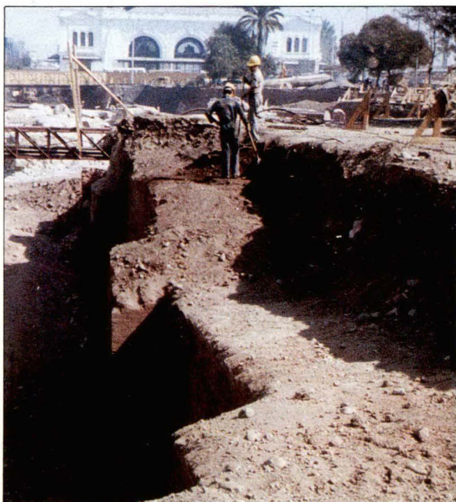
Foto 30 Contrafuertes traseros del tajamar.
