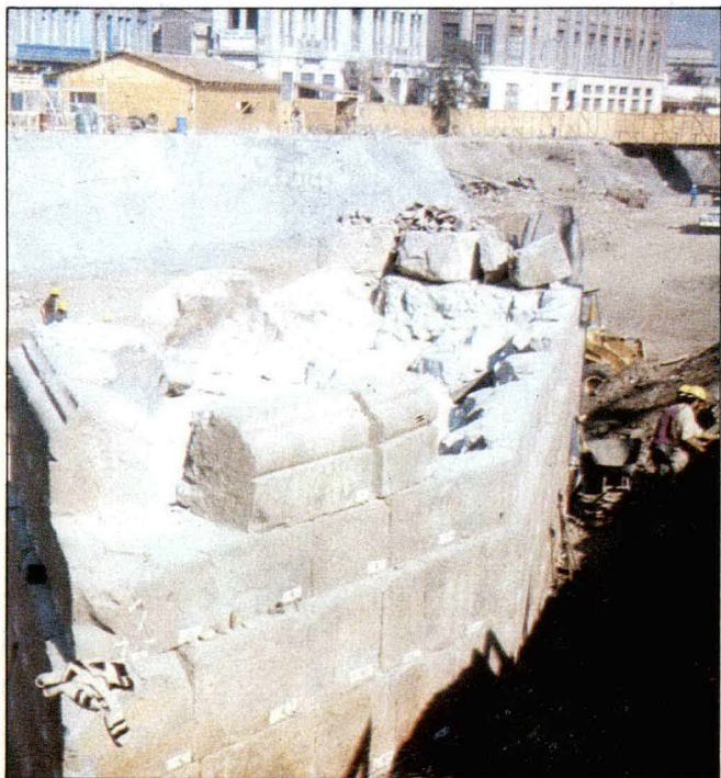
Foto 22 Cepa del Puente. Piedra exterior colorada. Piedra interior blanca.
