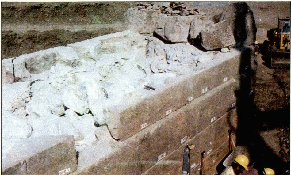
Foto 21 Cepa del Puente. Piedra exterior colorada. Piedra interior blanca.
